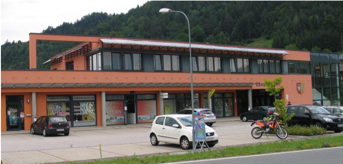
Abbildung: PV-Anlage in Sittersdorf (Ansicht Süd-West)
